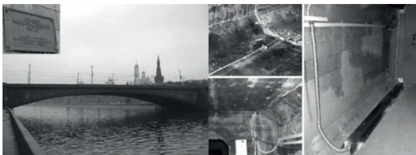
ภาพที่ ๒๐ สะพาน Bolshoi Moskvoretskiy Bridge และการติดตั้งระบบ Structural health monitoring system
